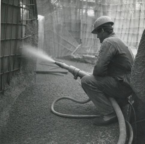
Gunitage (technique de projection du béton), vers 1966
